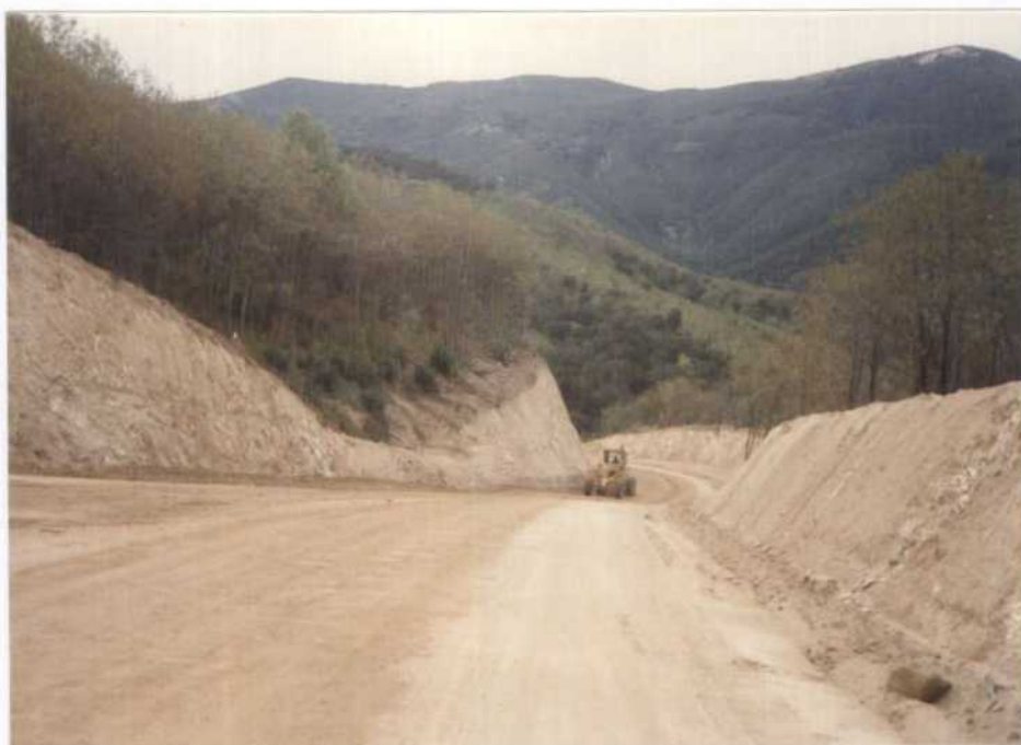
Foto 31 (60/E19).- Hoja 219. Aspecto que presenta los potentes recubrimientos en la carretera de Massanet de Cabrenys a Tapis.
